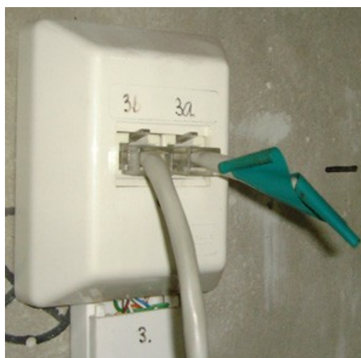
Rys.3 Podłączenie do gniazda jednej sondy
