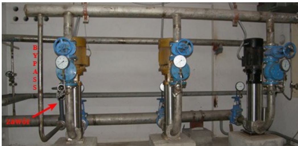
Rys.2 Pompy układu pierwotnego
