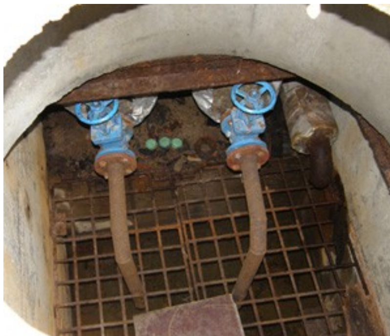
Rys.9 Zawory spustowe w studzience
